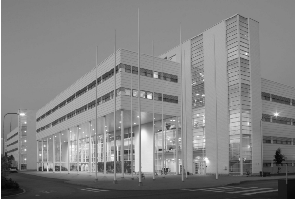
Kuva 1: Tiedekuntamme koti, Agora, on opetuksen, tutkimuksen ja yritysten kohtauspaikka.
